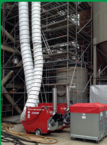
Für einen namhaften Automobilkonzern durften wir ein umfangreiches Bauvorhaben mit Winterbauheizung und -Trocknung begleiten. Zum Einsatz kamen 16 St. Mieteinheiten Jumbo 200 mit einer Heizleistung von 3.534 kW. Die Herausforderung dabei war das Umsetzen von Geräten, Tanks und Warmluftschläuchen, ohne den Baufortschritt zu behindern.
